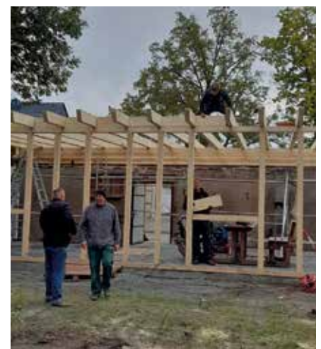
Der Dachstuhl wird aufgebaut
