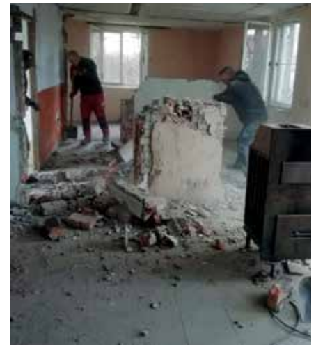
Bei den Entkernungsarbeiten
