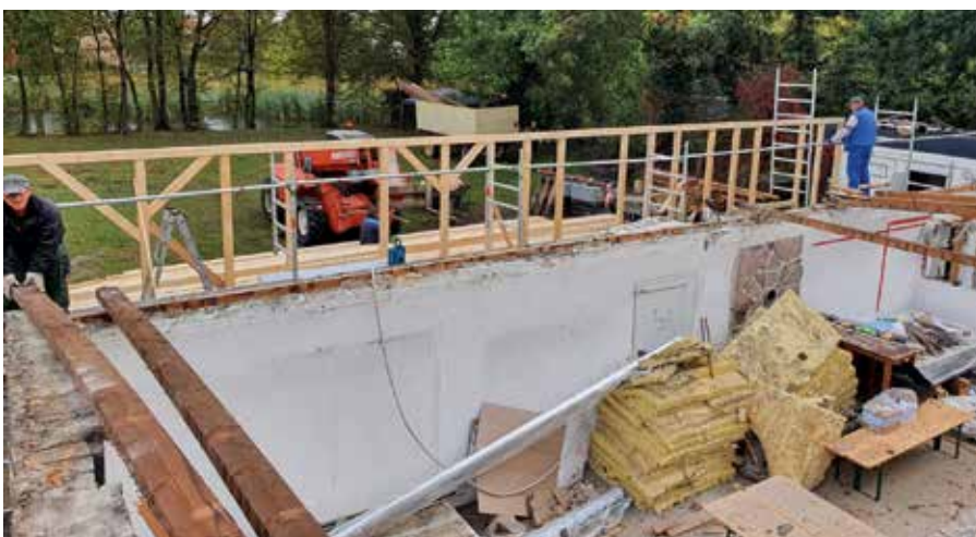
Abriss bis auf die Grundmauern
